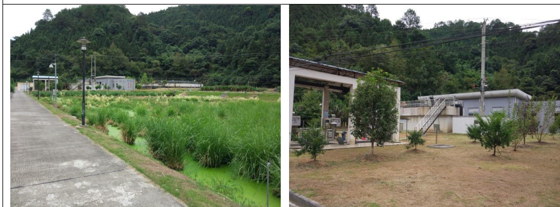
图 2 运行中的连山壮族瑶族自治县污水处理厂
