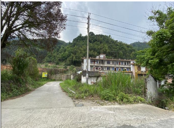
项目西面烟花爆竹公司旧宿舍楼
