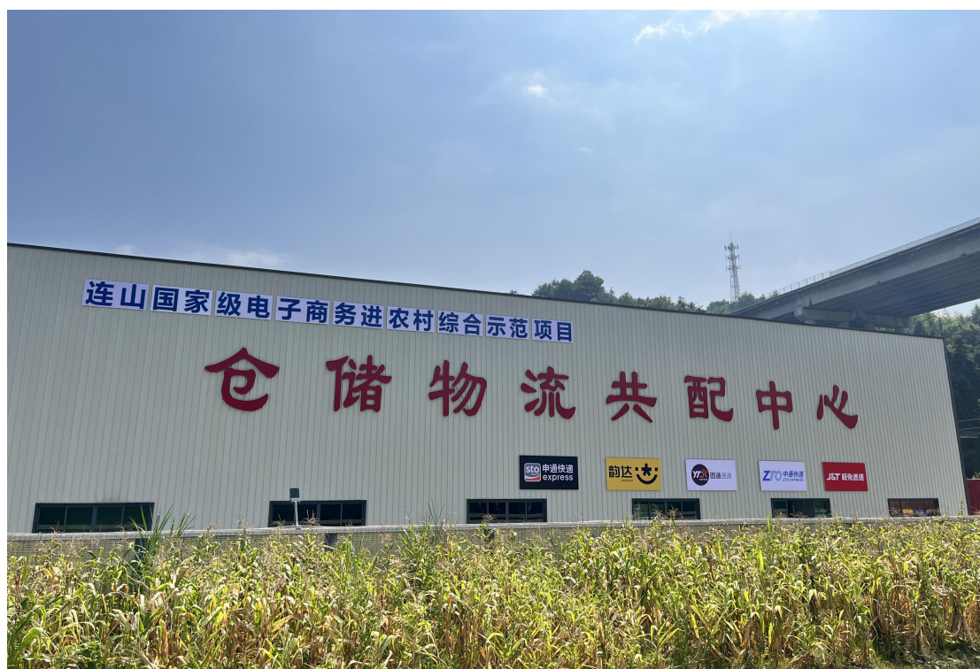
图 4-2 连山农村电商物流分拣（仓储）共配中心
